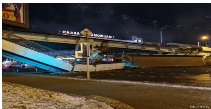
Рисунок 2 – Обвал пролета моста в г. Минске
