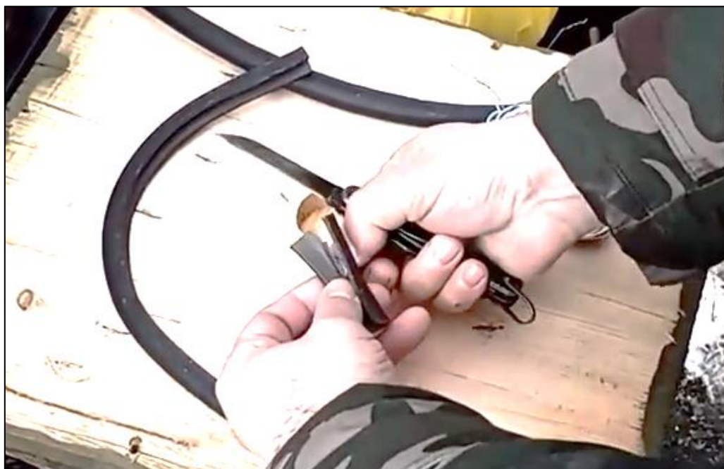
Рисунок 5 – Выполненная продольная прорезь в ШКЗ
